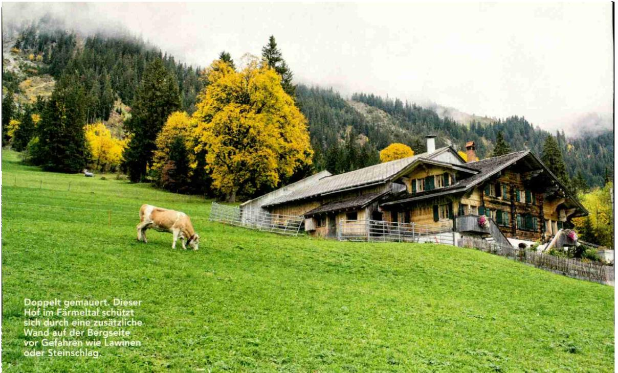
Doppelt gemauert. Dieser Hof im Färmeltal schützt sich durch eine zusätzliche Wand auf der Bergseite vor Gefahren wie Lawinen oder Steinschlag.
