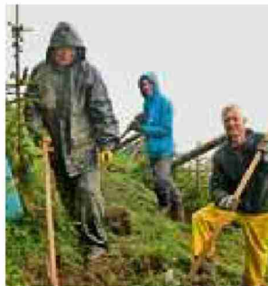
In steilem Gelände: Die Gruppe mit der Wiedehopfhacke beim Wegbau.
