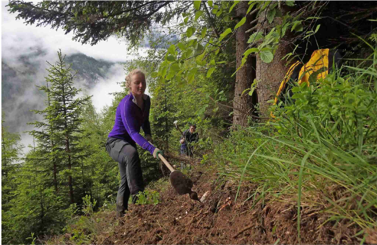
Gruppenleiterin Svenja hackt mit dem «Wiedehopf» einen forstlichen Begehungsweg, der künftig die Pflege des Ankerwaldes ob Saxeten erleichtert. Foto: Sibylle Hunziker
