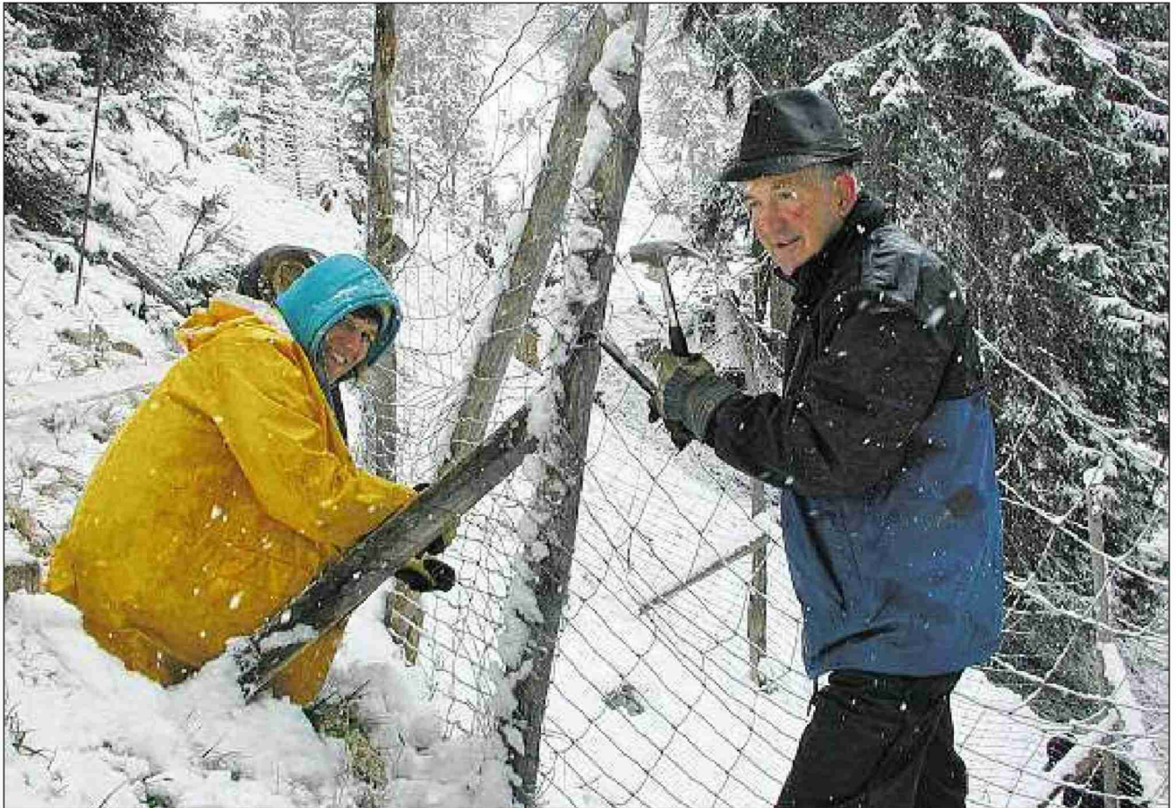
Ein durch Schneedruck beschädigtes Drahtgeflecht wird instand gestellt.
