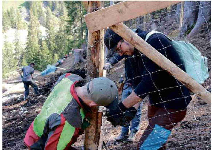
Angepackt beim Bau eines Kontrollzauns.
