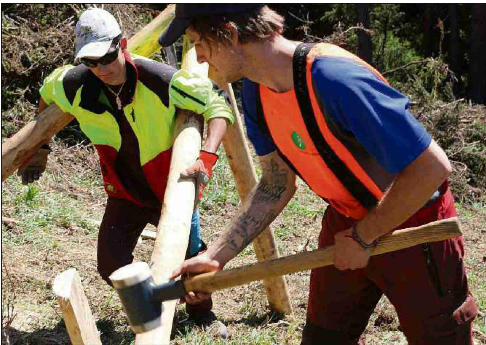
Beim Pflöcke einschlagen für die Dreibein-Böcke.
