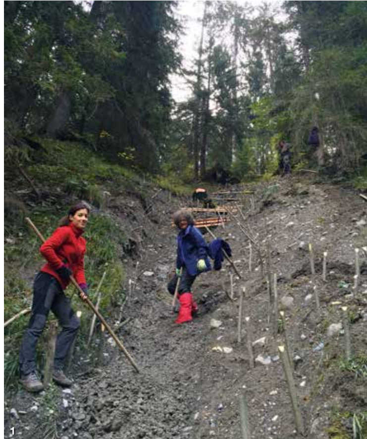
Bild 1: Hier werden Weiden gesteckt, als Erosionsschutz | Bild 2: Die Freiwilligen durchforsten den Schutzwald
