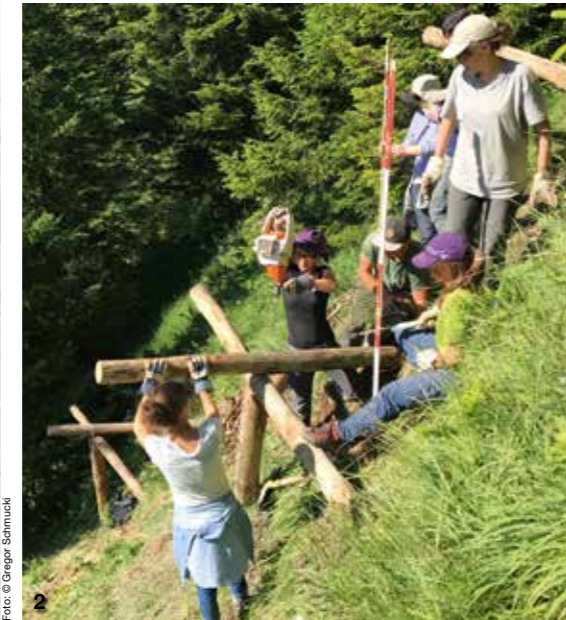
Bild 1: Freiwillige platzieren einen Steher in Giswil OW | Bild 2: Freiwillige positionieren die Schenkel im Taminatal SG | Bild 3: Der Winkel ist entscheidend (Taminatal SG)
