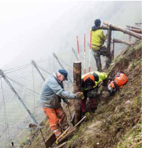
Bild 1: Freiwillige platzieren einen Steher in Giswil OW | Bild 2: Freiwillige positionieren die Schenkel im Taminatal SG | Bild 3: Der Winkel ist entscheidend (Taminatal SG)
