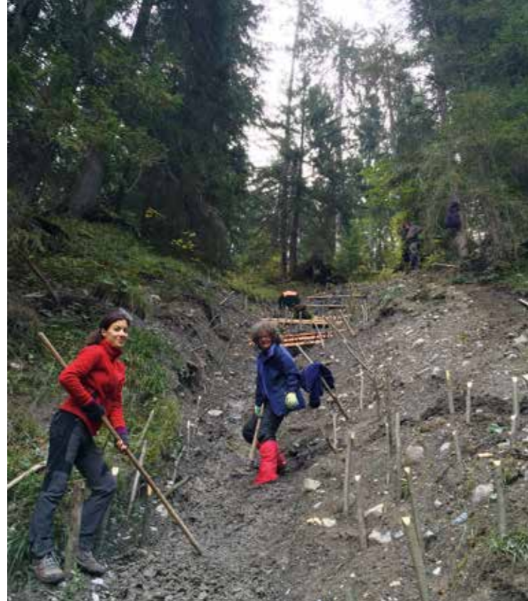
Zum Bild links: Mit Weidenstecklingen wird die Erosion in St. Stephan gestoppt
